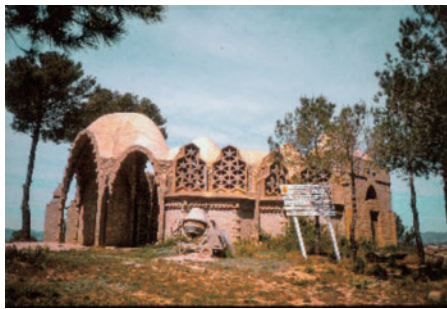
Fig.1)* Iglesia de Montferri / 未完遺構当時 1989.
