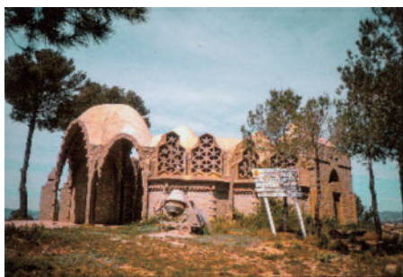
Fig.1)* Iglesia de Montferri / 未完遺構当時 1989.
