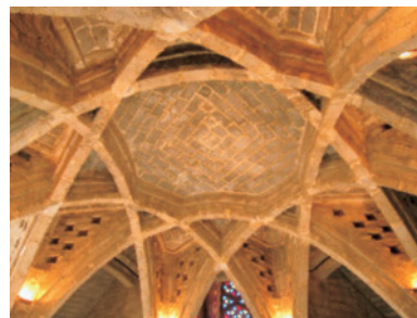
Fig.50)* Montferri 遺構後陣 1F 天井“オージヴ”, 2010.
