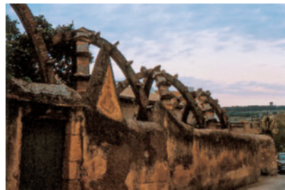
Fig.41) * Casa Bofarull (1914) の屋外洗濯場, 1989.
